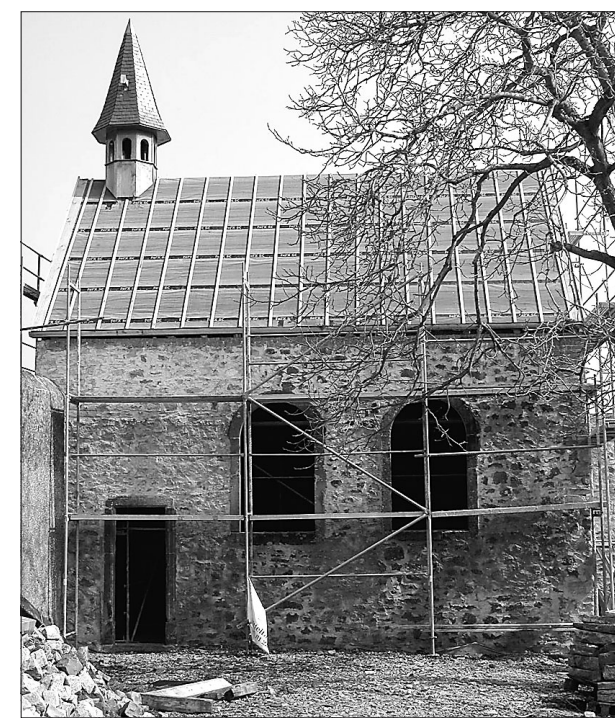
Die Restaurierungsarbeiten der Kapelle „op Birelerhaff“ schreiten voran (Photo: M. Wagner)
